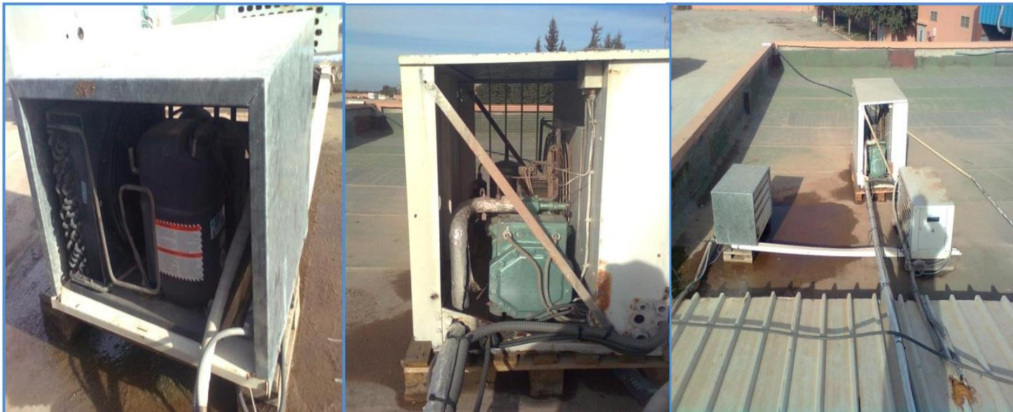
Composé à un évaporateur qui à aliment par un group frigorifique de **R404A** avec un moteur compresseur à **2** pistons « BITZER »
